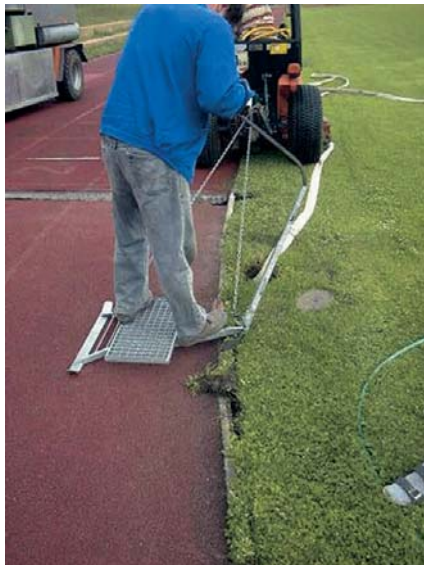
Freischneiden der Rasensode außerhalb der Randeinfassung 07
