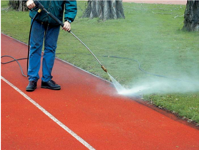
Reinigung mit Hochdruckwasserstrahl 05
