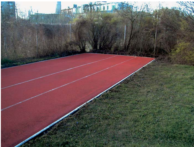
Kunststoffbelaglaufbahn nach Tiefenreinigung mit Schmutzwasserabsaugung 10
