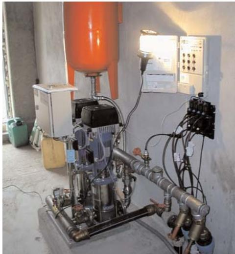
Drehzahlgeregelte Drucksteigerungsanlage <sup>10</sup>
