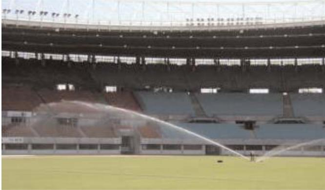
Betrieb einer Versenkregneranlage <sup>07</sup>
